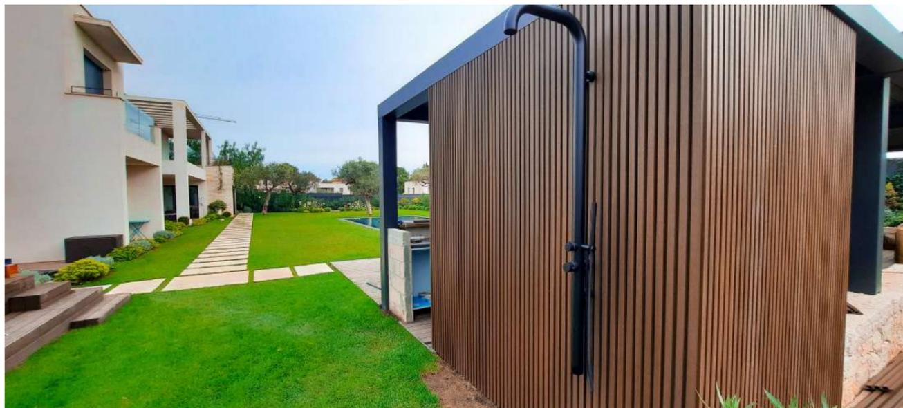
Les lames de bardage WEO 35 ® se posent très facilement grâce au système d'emboîtement par rainure-langue. Le remplacement d'une lame est d'une extrême simplicité pour faciliter les opérations de maintenance. L'entraxe entre les supports est de 40cm ou 60cm selon l'exposition des façades extérieures. Les vis inox SR2 4.2x38mm WEO, quasiment invisibles grâce à leur tête de couleur assortie aux lames, sont fournies avec les panneaux.
