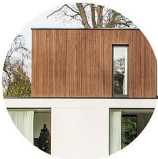
BARDAGE MUR EXTERIEUR
